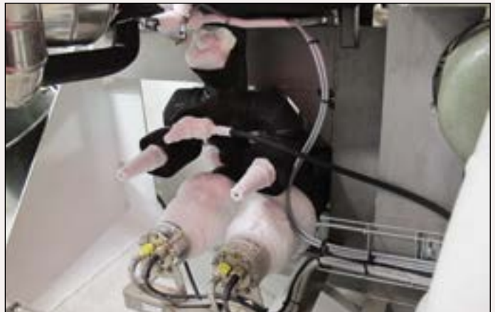
Væskepumpene på kuldeanlegget som pumper -50graders CO 2 ut til platefryserne.
