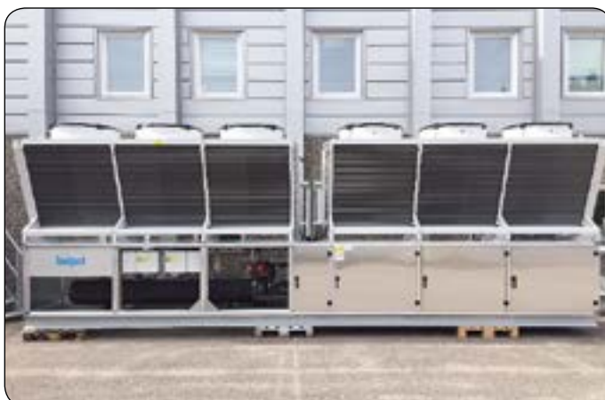
De største anlæg kan veje op til 6 ton og da må man tage hensyn til om den bærende konstruktion kan bære vægten.
