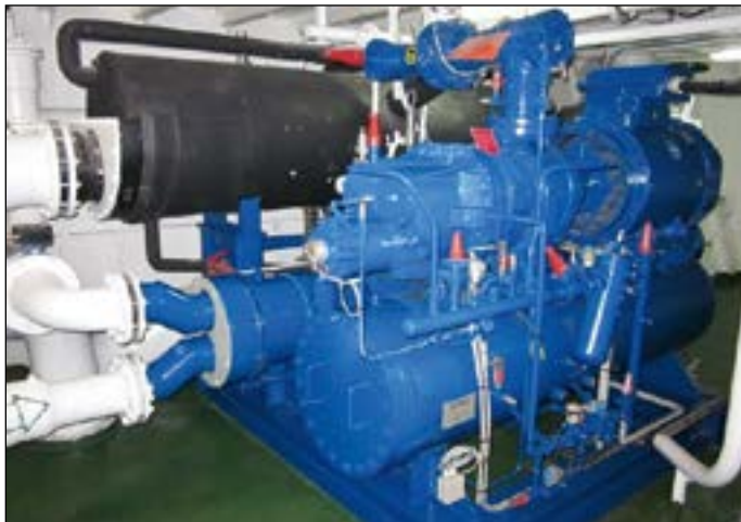
RSW-anlegg leveres som flux-anlegg med ammoniakk som kulde-medium.
